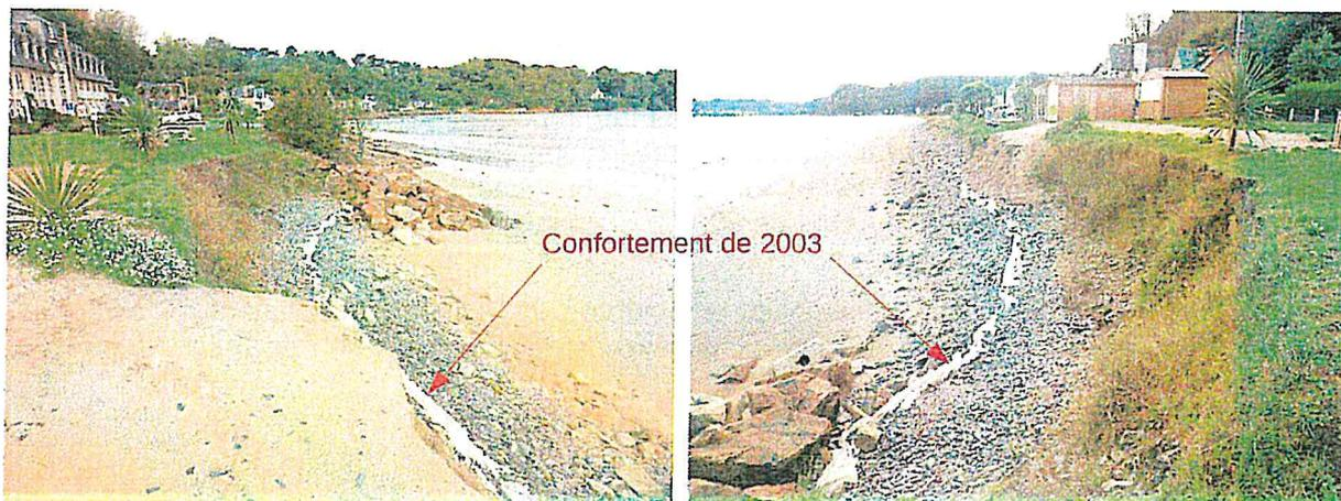
Illustration 30: Vues du recul du trait de côte depuis la plate-forme littorale dans l'alignement des enrochements. On constate aussi les restes de l'ouvrage en géotextile qui sont affleurants au droit du cordon de galets
