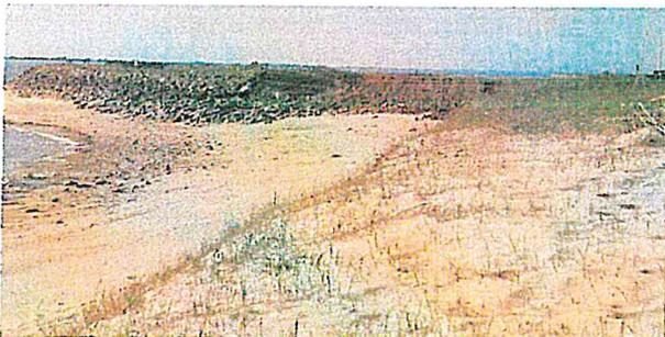
Illustration 54: Exemple d'érosion au bout d'un ouvrage en enrochements – cordon dunaire à Treffogat (29).
