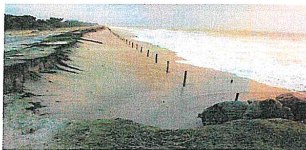
Illustration 55: Exemple d'érosion à l'extrémité d'un ouvrage en enrochements – cordon dunaire à Fouesnant (29)
